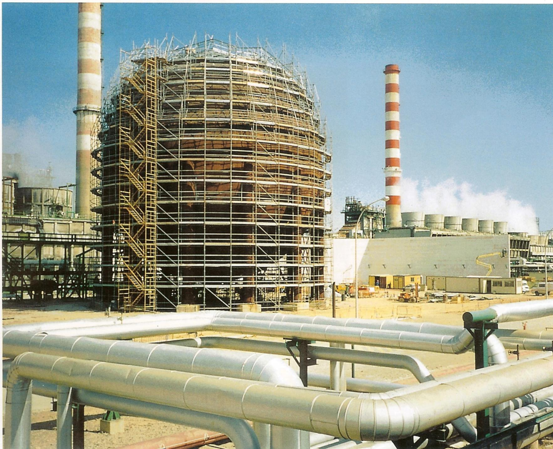
Na reparação e manutenção industrial o factor económico é conseguido ao permitir a montagem e desmontagem rápida e fácil sem impedir o normal funcionamento da actividade fabril.
